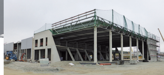
... und so sah es Anfang Oktober 2015 als brummende Baustelle aus.
