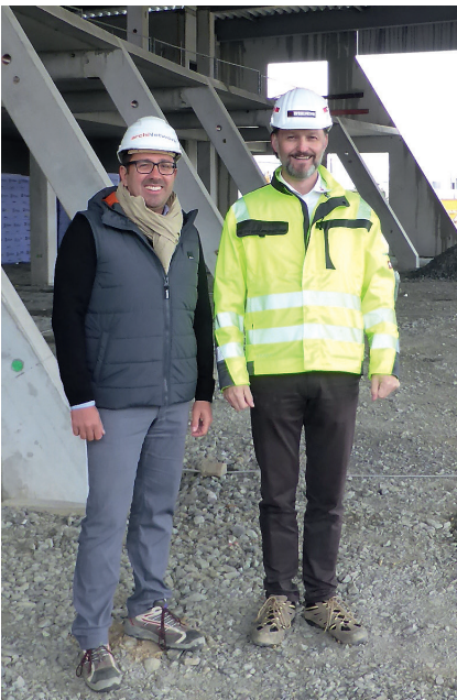
Auf der Baustelle: Roman Fehling (r.) und Architekt Michael Schramm (archiNetwork)
